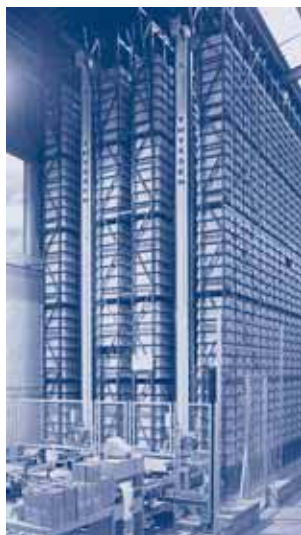
Fig. 3.9. Entre los costes hay que considerar tanto los del edificio como los de las instalaciones.
