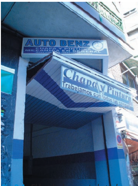
Fig.2.1. El local o la nave industrial deben estar debidamente acondicionados para el trabajo que vamos a desempeñar y, de ese modo, optimizar los resultados.
