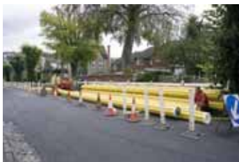
Obres de canalització i instal·lació de gas.
