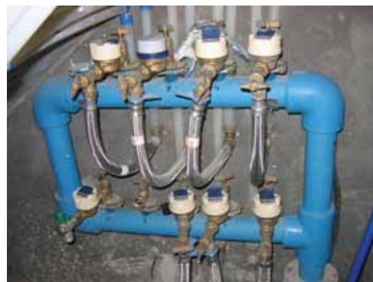
Comptadors d'aigua i claus de pas individuals d'un bloc de pisos.
