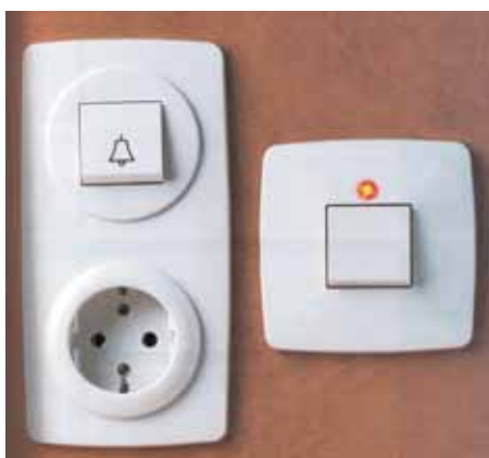
Aparells de comandament i endoll amb presa de terra.
